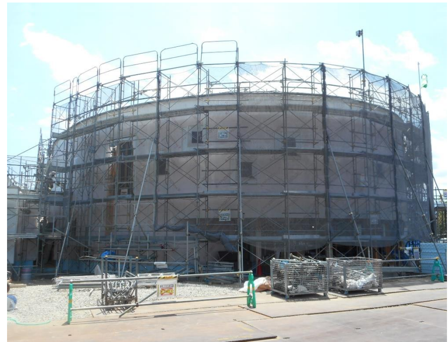
【工事中 令和5年7月】
