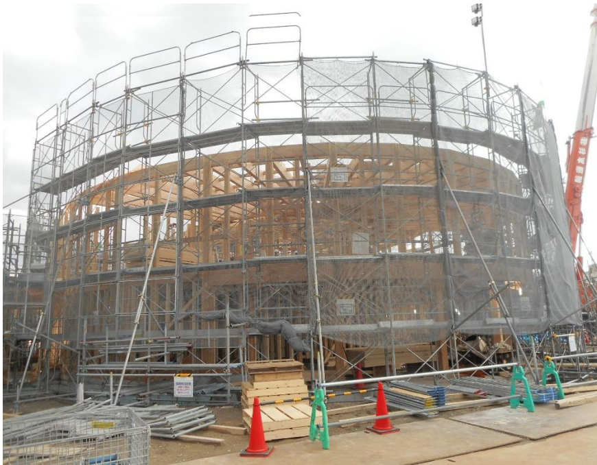
【工事中 令和5年4月】
