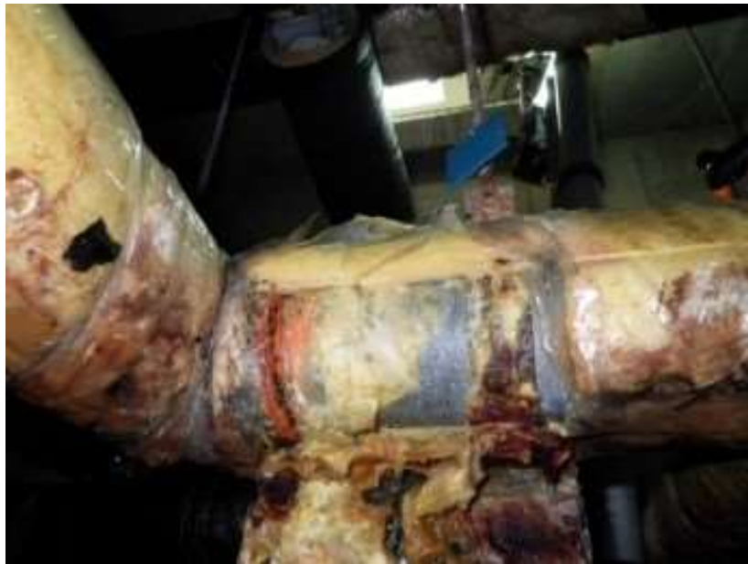
給排水設備の配管の腐食状況
