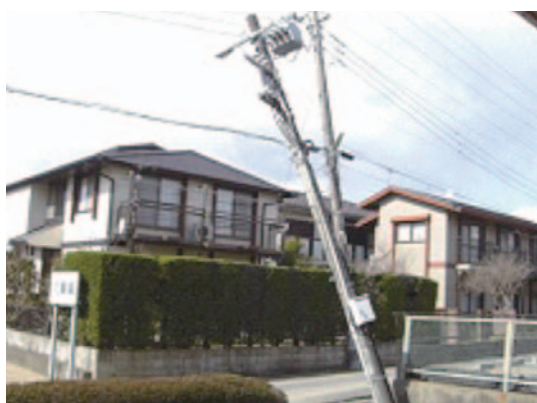
▲東日本大震災では、電柱の倒壊などによって大規模な停電が生じ、災害拠点病院等の診療機能は大幅に低下しました。
