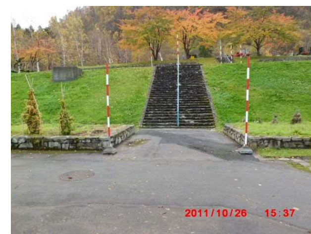
除雪指示していない階段 (管理事務所側)
