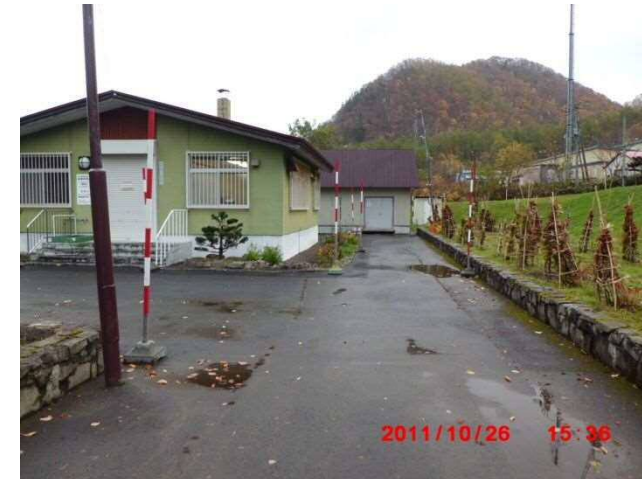
管理事務所正面右から倉庫方向
