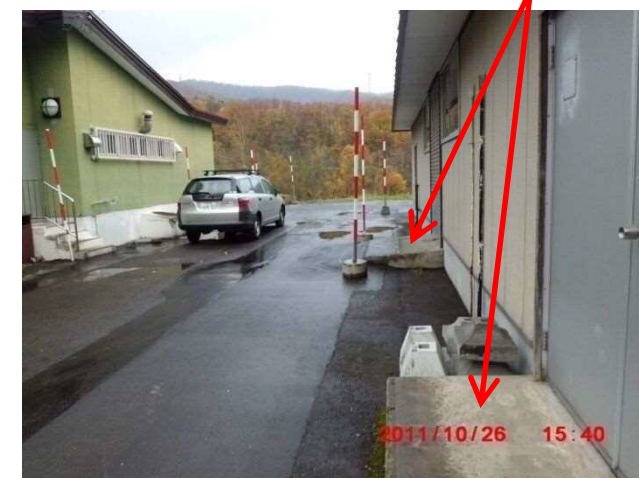
ポンプ室兼倉庫前の様子
