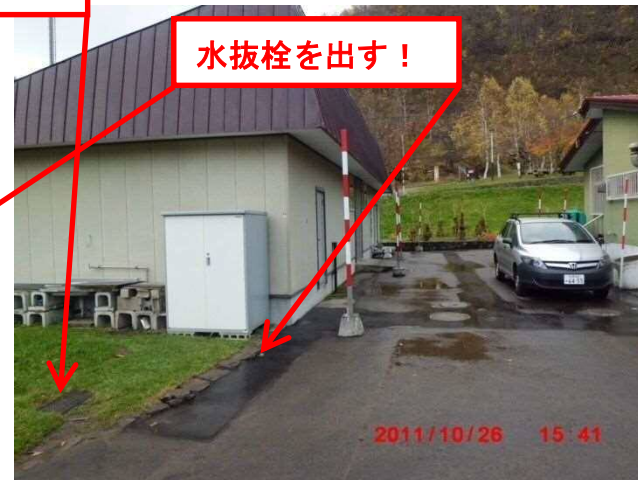
進入路から見たポンプ室兼倉庫
