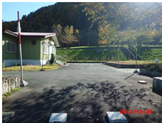
進入路突端からの管理事務所前
