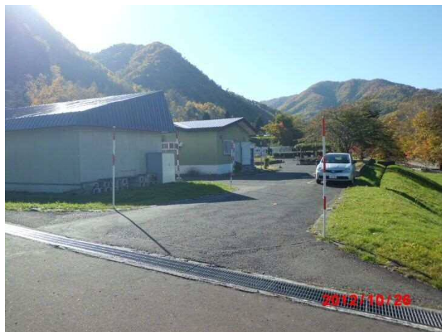
管理事務所進入路
