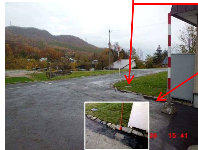
ポンプ室前から見た進入路
