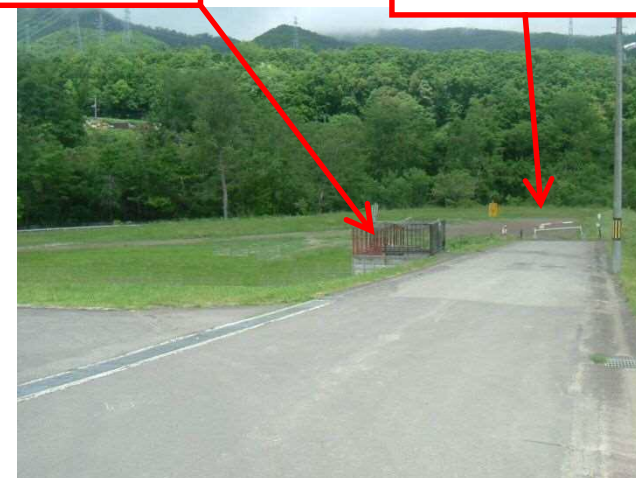
左折 管理事務所 直進 広場
