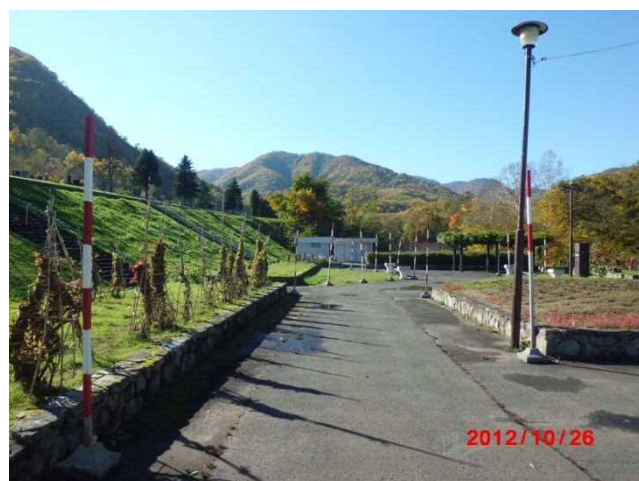
管理事務所正面右からトイレ方向
