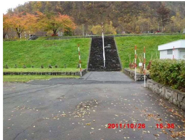
除雪指示していない階段(トイレ側)
