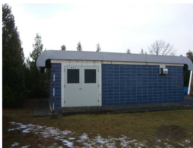
管理事務所裏側機械室
