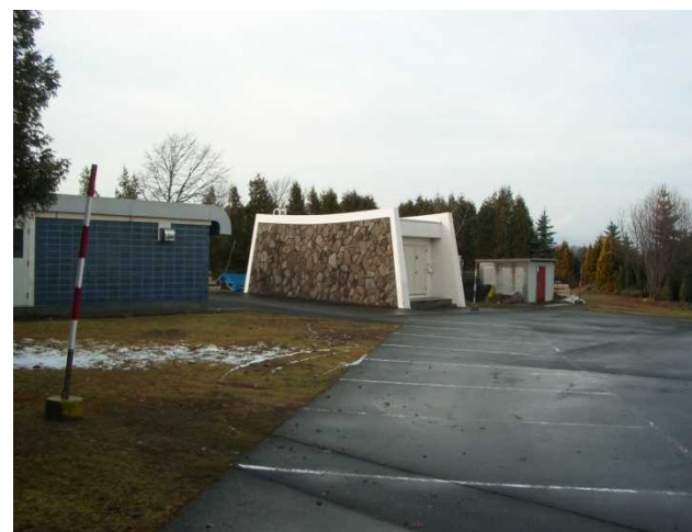
管理事務所裏側の進入路方向の様子
