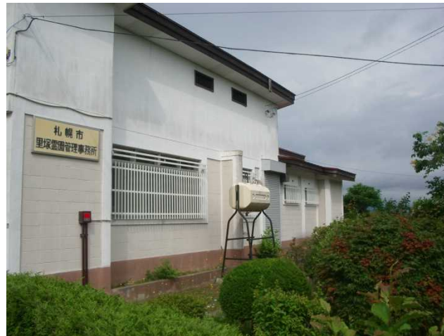
市道側に面した管理事務所の様子
