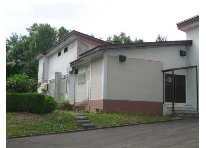
市道側に面した管理事務所裏口側
