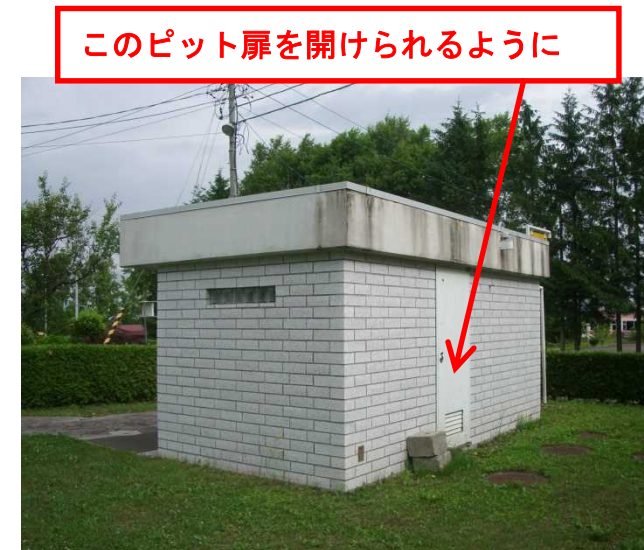
トイレ裏側の様子
