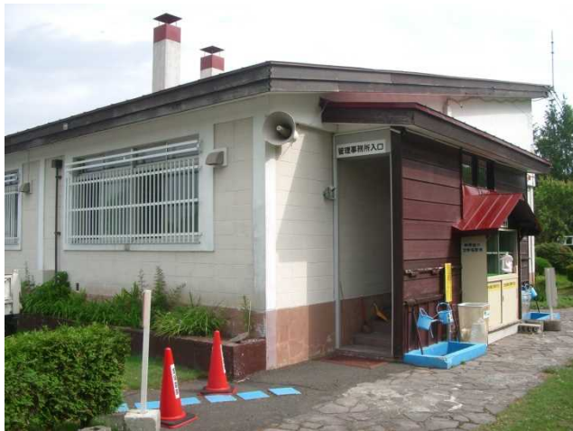
裏側から見た管理事務所入口
