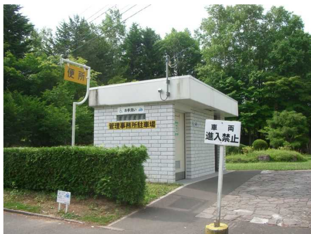
市道側から見た管理事務所前トイレ
