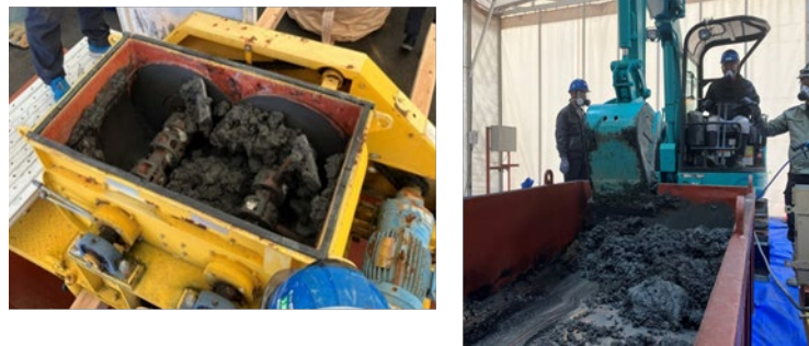
図 9 資材混合状況（左：小型攪拌装置、右：小型バックホウ）（No. S4）
