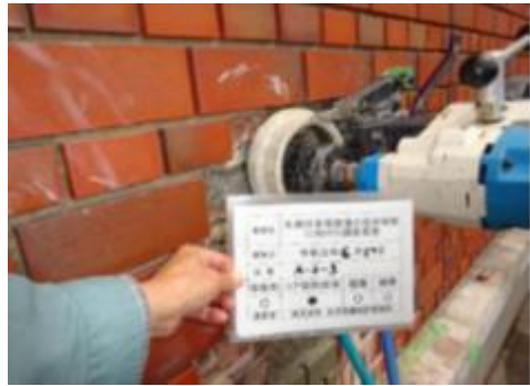
コンクリートのコア抜き
