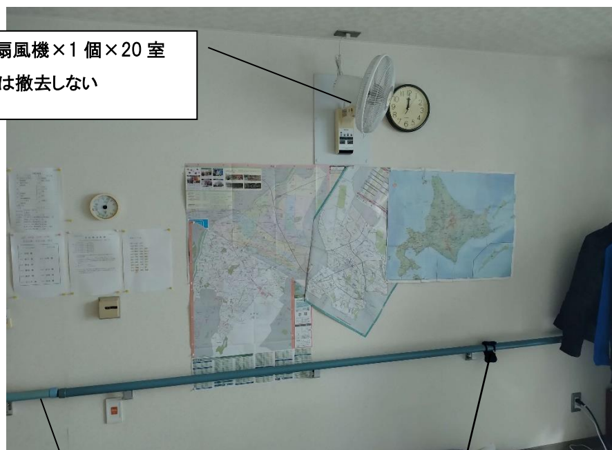
手摺(長)×1個×20室 サイズ(3080mm)撤去 撤去後壁補修 ※手摺(短)【710mm】は撤去しない
