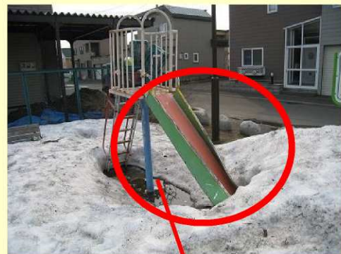
すべり台：滑走部分の破損
