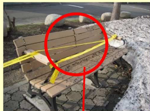
ベンチ：背板の破損
