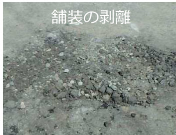
雨水枡角の舗装剥離
