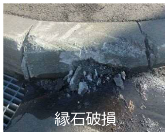
雨水枡角の舗装剥離
