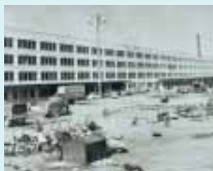
札幌駅新築 (昭27.12) 明治の駅舎に代わって新築の札幌駅
