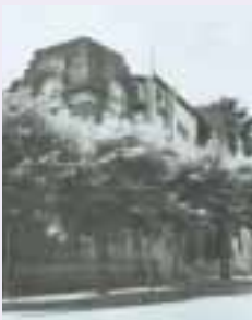
豊平館新館(公会堂) 落成(その後旧市民会館へ) (昭2.11) 豊平館の裏手に建設された公会堂は、1階に1,500名収容の大集会場がありました。
