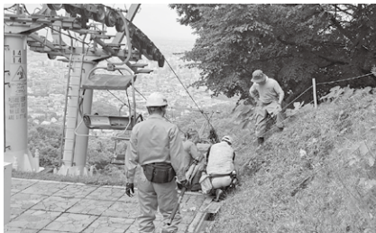
電気柵を設置している様子
