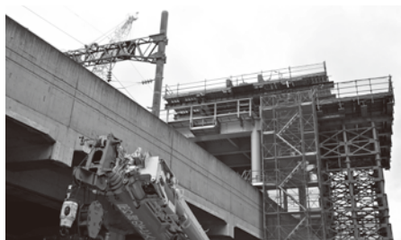
JR札幌駅工事の様子
