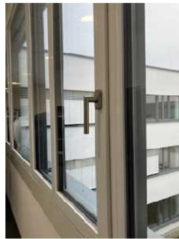
パッシブ工法による三層構造の窓
