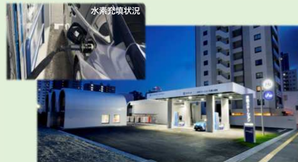
【図15 水素ステーション札幌大通東(R7年4月開業)】
