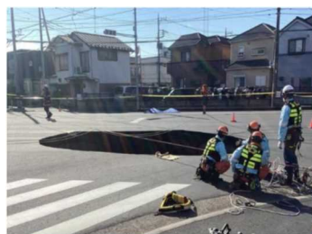
写真：道路陥没の事例
