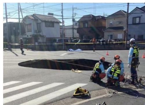
写真：道路陥没の事例
