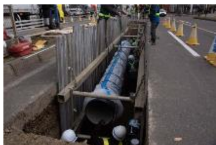
配水管の布設替え
