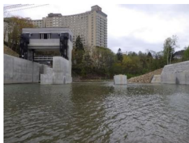
玉川橋取水堰 (豊平川水道水源水質保全事業)
