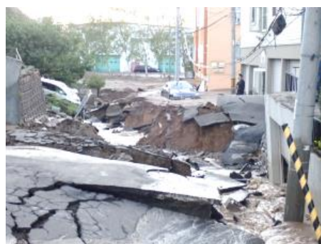
液状化による陥没
