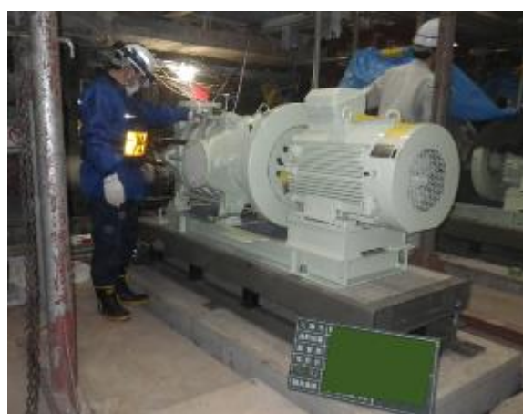
ポンプ設備更新工事
