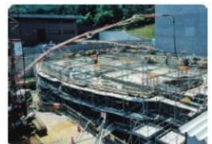
藻岩浄水場改修工事 (平成9～15年)
