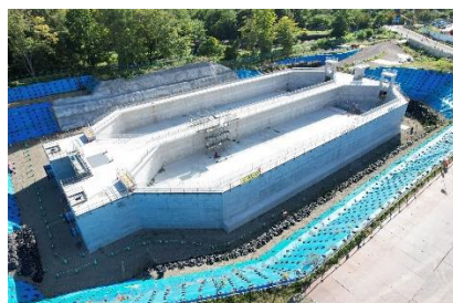
白川新沈砂池の建設（白川浄水場改修事業）
