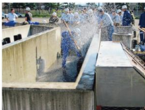
漏水修理実習
