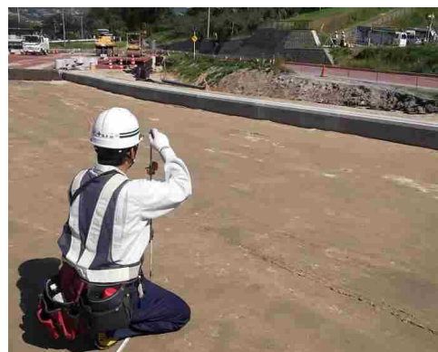
ICTを活用した出来形管理
