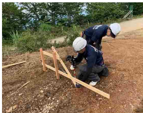
ICTを活用した丁張作業
