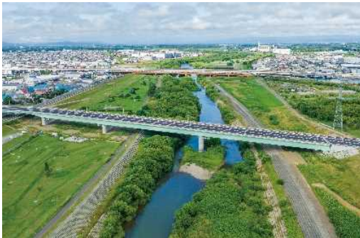
道路・橋梁の整備
