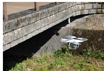
ドローンを使った橋梁の点検
