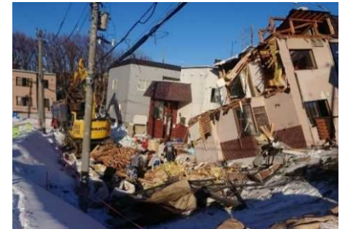
平成30年北海道胆振東部地震 での被災家屋の除去
