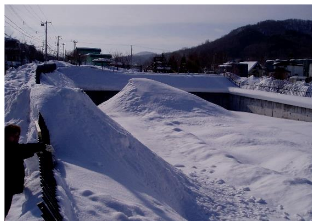
雨水貯留池の活用
