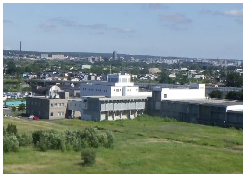
東部水再生プラザ
