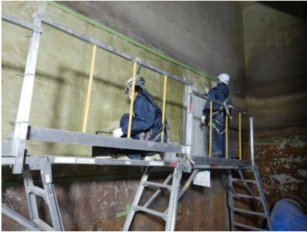
水槽の防食塗装の修繕
