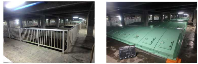
施工前 水再生プラザの覆蓋 施工後
