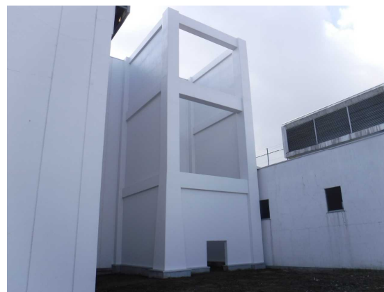
揚水施設の耐震化(フレーム補強)
