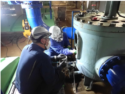
機械設備の清掃
