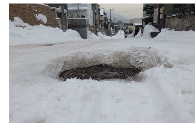
下水道マンホールによる積雪時の段差状況
