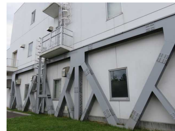
管理棟の耐震化(鉄骨ブレース)
