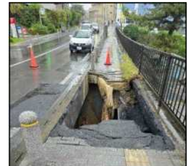
管路施設に起因した道路陥没事故(出典:国土交通省)
