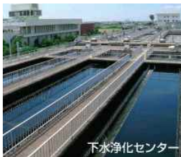
下水浄化センター
