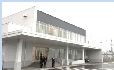
福岡市第3給食センター外観
