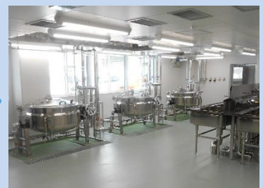
ドライシステムの給食調理室
