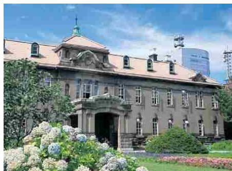
旧札幌控訴院庁舎(重要文化財)
