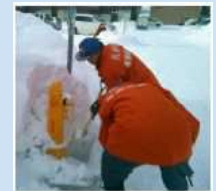
消火栓除雪の状況
