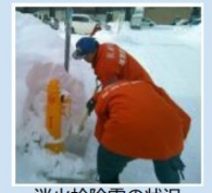
消火栓除雪の状況
