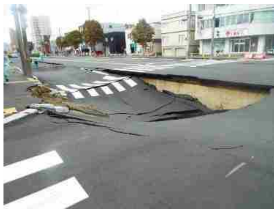
図 2-33 地震発生後の道路陥没のようす (平成30年北海道胆振東部地震) 資料：札幌市
