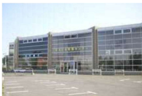
写真 2.3 もみじ台管理センター外観
