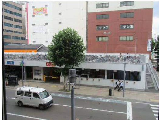
図 2-28 民間の青空駐車場の上空を活用した公共駐輪場整備（南2西4五番街駐輪場）
