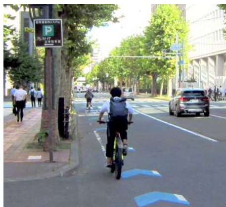
図 2-21 矢羽根型路面表示の整備事例
