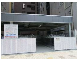
図 4-15 新設の路外駐輪場
