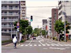
◀ 幅員構成の見直しによる自転車走行環境の改善事例（北12条線）
