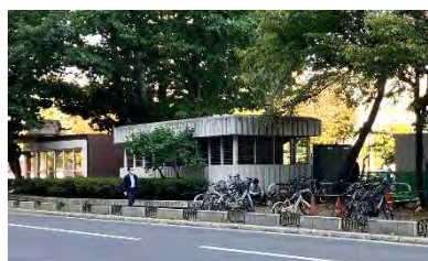
西10丁目 通気口 (公園南側)
