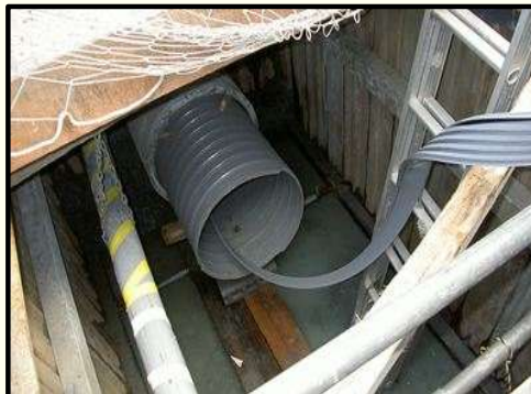
管更生工法による改築
