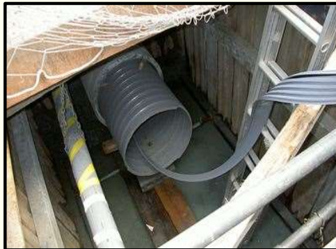
管更生工法による改築
