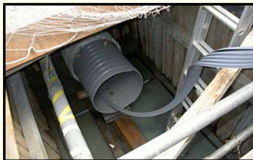
管更生工法による改築
