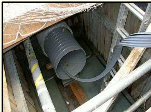
管更生工法による改築
