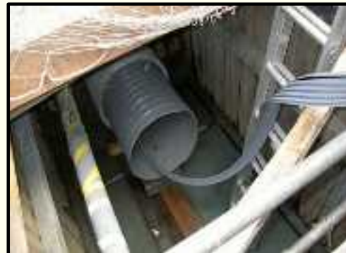
管更生工法による改築
