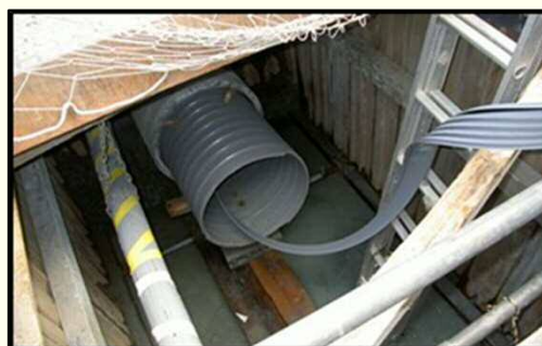
管更生工法による改築
