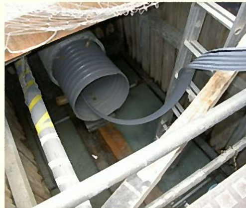
古い管の内側に新たに樹脂製の管を生成
