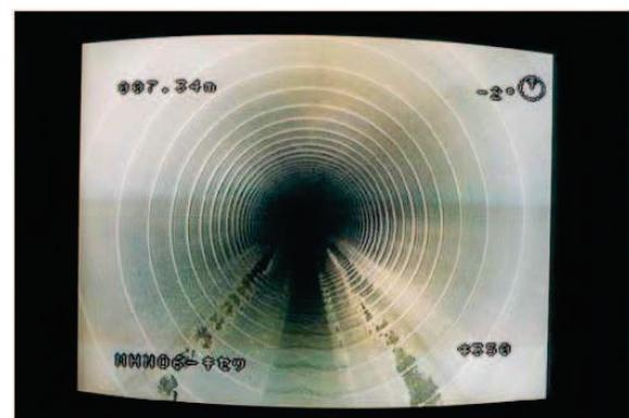
管更生工法による管路の改築
