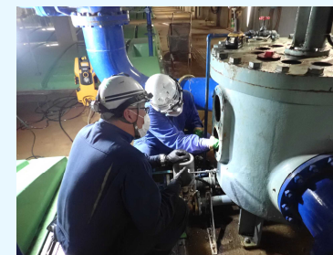
機械設備の清掃
