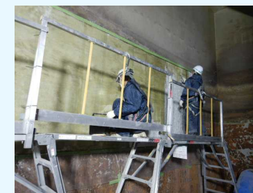
水槽の防食塗装の修繕
