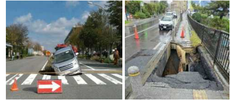
管路施設に起因した道路陥没事故 (出典:国土交通省)
