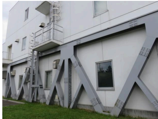
揚水施設の耐震化(外部補強)
