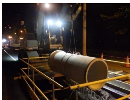
管路の耐震化(管路の入れ替え)
