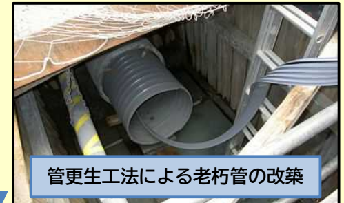
昭和初期に整備した下水管(老朽管)
