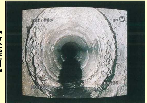
昭和初期に整備した下水管(老朽管)
