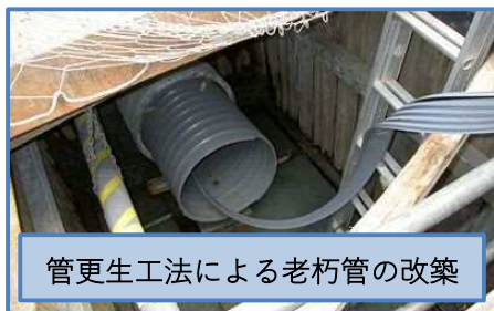
昭和初期に整備した下水管（老朽管）
