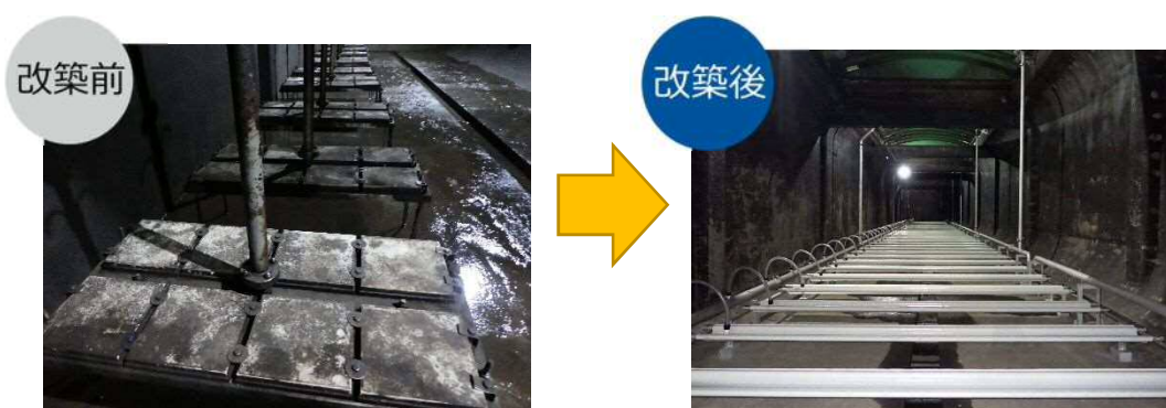
機械設備の改築（散気装置）
