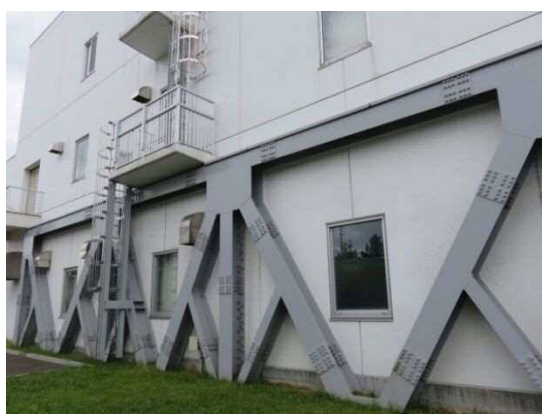
揚水施設の耐震化（外部補強）
