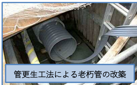
昭和初期に整備した下水管（老朽管）
