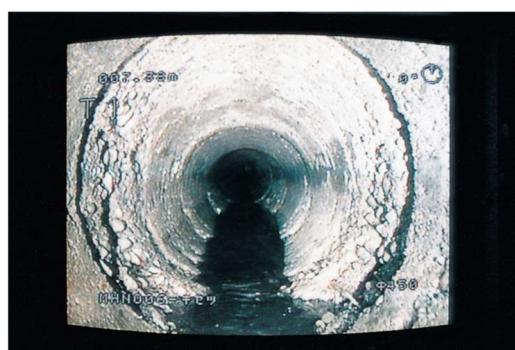
管更生工法による管路の改築
