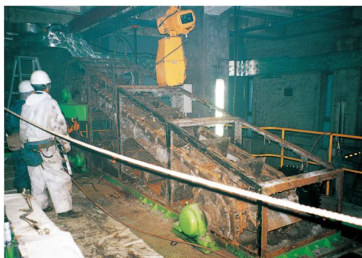
老朽化したコンベヤ設備の改築
