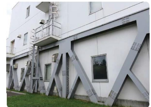
揚水施設の耐震化(外部補強)
