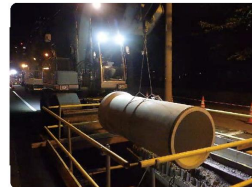
管路の耐震化(管の入れ替え)
