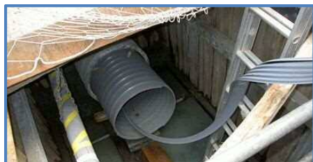
管更生工法による老朽管の改築
